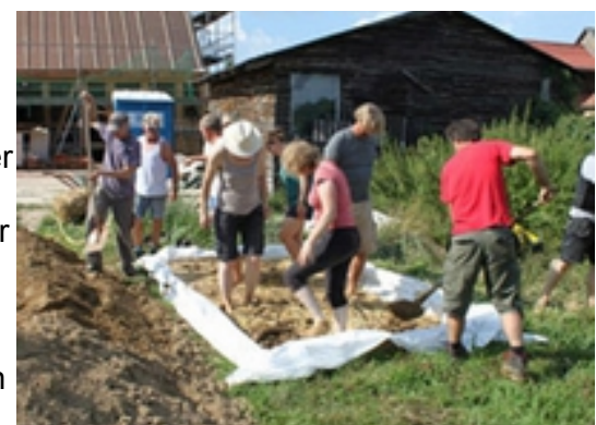
Der Lehm wird mit Wasser und Stroh vermischt und in eine verarbeitungsfähige Konsistenz gebracht.
