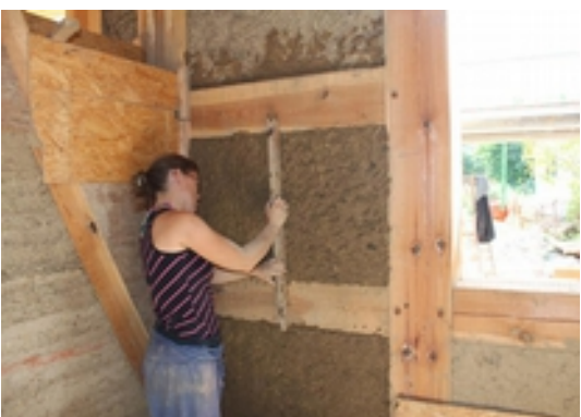
Der Lehmputz wird glatt gestrichen
