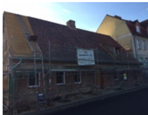
Nordseitig, Ziegeleindeckung des Gebäudes. Foto: R. Vögel
