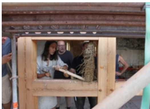
Eine Wickelstake wird eingesetzt
